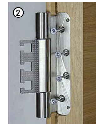
2 Band mit mitgelieferten Holzschrauben 5,0 x 50 befestigen
