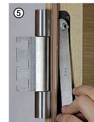
5 Edelstahlabdeckung einsetzen
