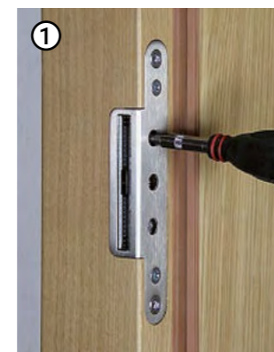
1 Klemmschrauben C leicht lösen
