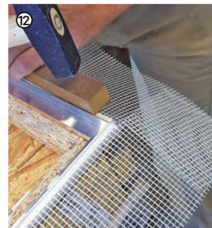
12 Mit Beilage einklopfen, damit sie richtig einklippen.
