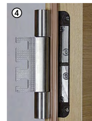
4 Überschlafdichtung einziehen
