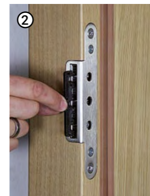
2 Kunststoffeinsatz zwischen den Klemmplatten herausziehen. (Dient nur zur Schraubensicherung während des Transports)
