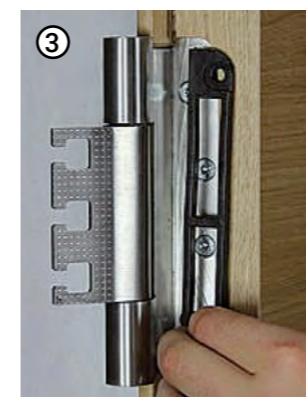
3 Kunststoffeinsatz einsetzen
